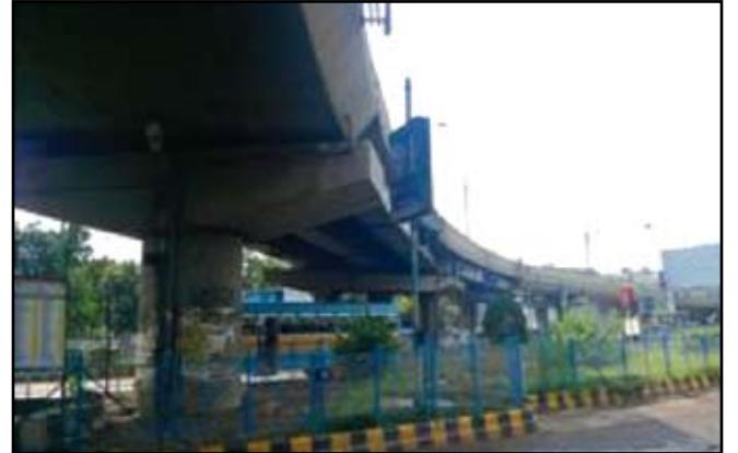
(ख) डीएलएफ फ्लाईओवर/बॉगजोला कनाल सेतु
