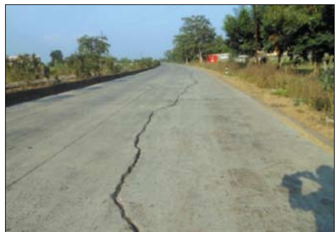
चित्र 33 – रायपुर और बिलासपुर खंड पर चौड़े और चिपड़युक्त अनुदैर्घ्य विदारण
