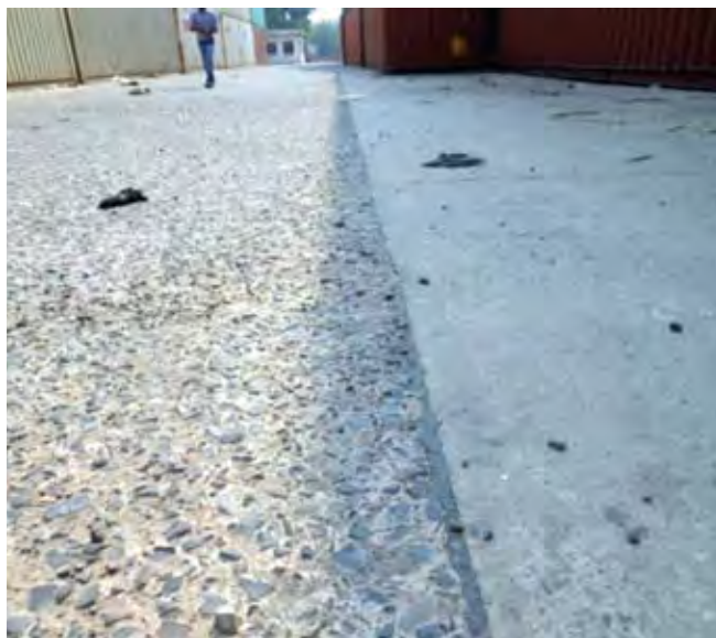
चित्र 66 : यातायात के कारण अपघर्षित सड़क सतह
