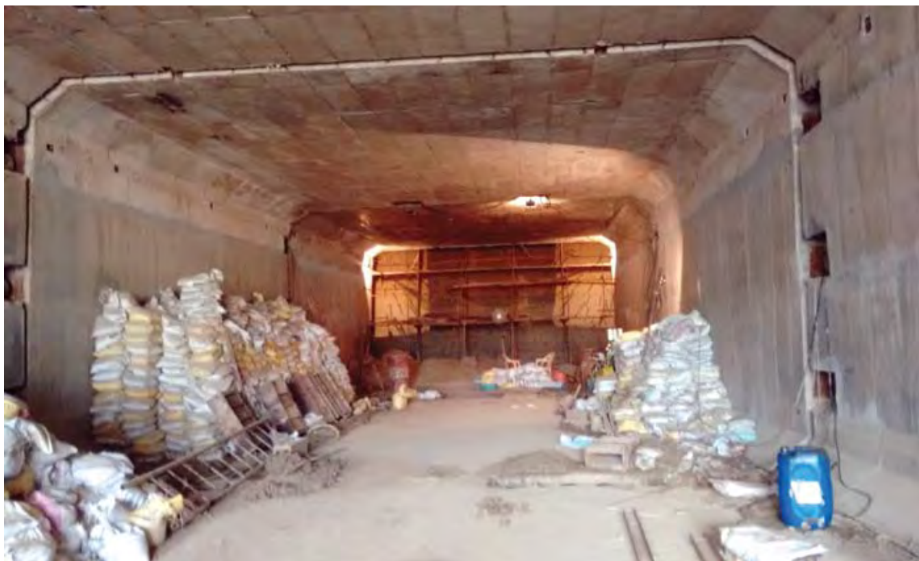
चित्र 21 : बक्सा धकेलने का कार्य प्रगति पर
