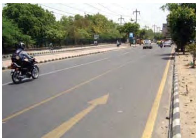
चित्र 70 : मां आनंदमयी मार्ग पर अपशिष्ट प्लास्टिक के प्रयोग से तप्त एस्फाल्ट मिश्रण सतह
