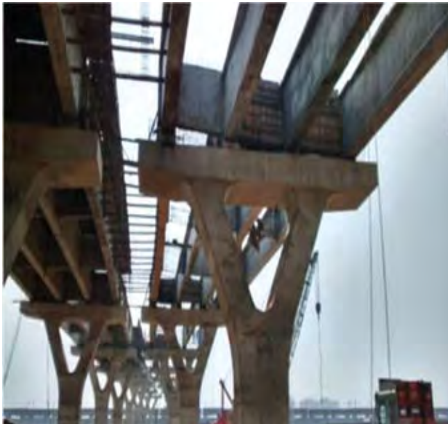
चित्र 95 : निर्माणाधीन पीएससी सेतु
