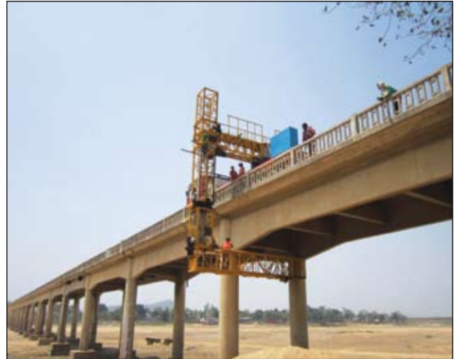
चित्र 58 : झारखंड-छत्तीसगढ़ सीमा के पास एमबीआईयू के माध्यम से सेतु का स्थिति सर्वेक्षण
