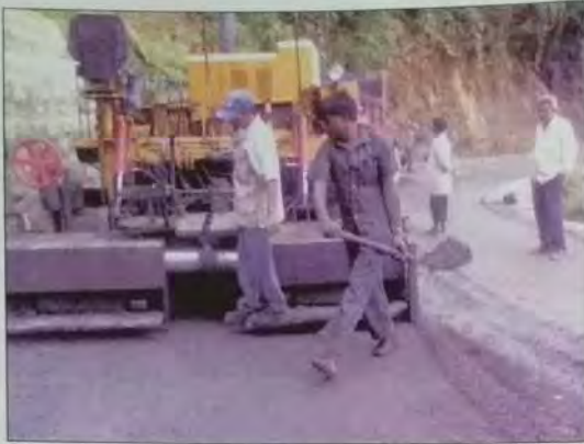
चित्र 33 : आइजोल बाइपास (मिजोरम) पर परीक्षण खंडों का निर्माण
