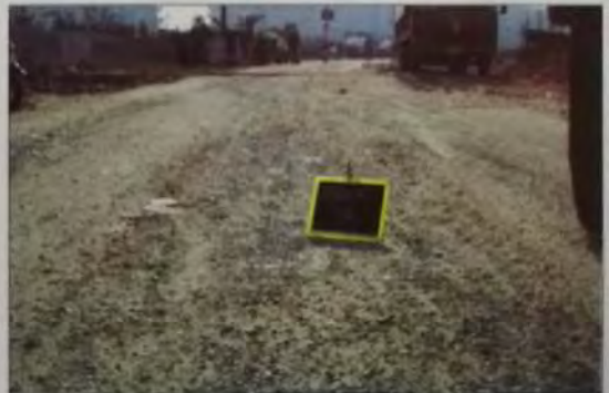
चित्र 68 : परियोजना सड़कों में से एक सड़क पर खराब सतह दशा
