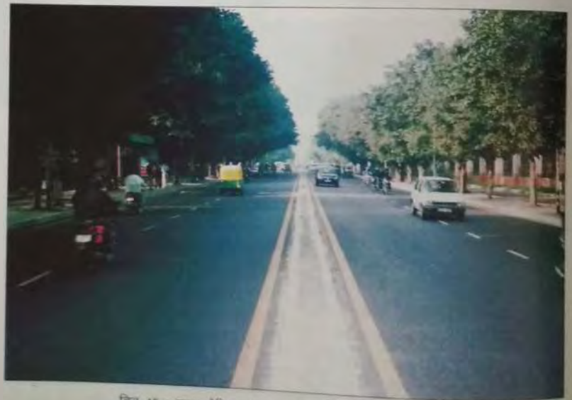
चित्र 45 : प्रस्तर मैट्रिक्स एस्फाल्ट मिश्रण की अंतिम सतह बनावट
