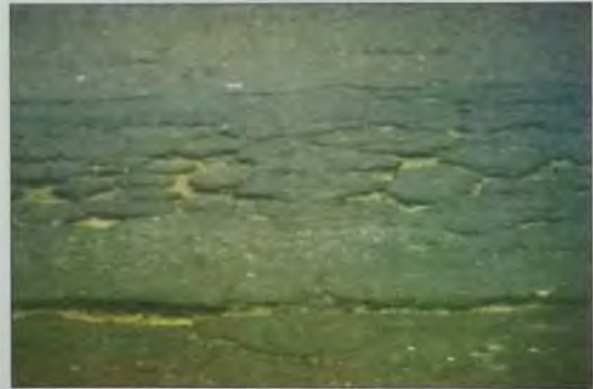
चित्र 74 : गहरी सतही दरारों के परिणामस्वरूप गड्ढों का निर्माण एवं सामग्री की हानि
