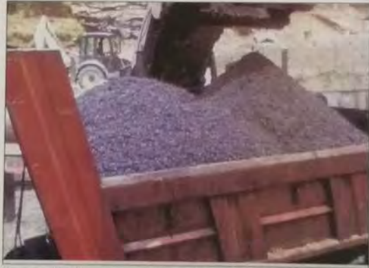
चित्र 32 : आइजोल बाइपास पर परीक्षण खंडों के निर्माण हेतु शीत मिश्र का उत्पादन
