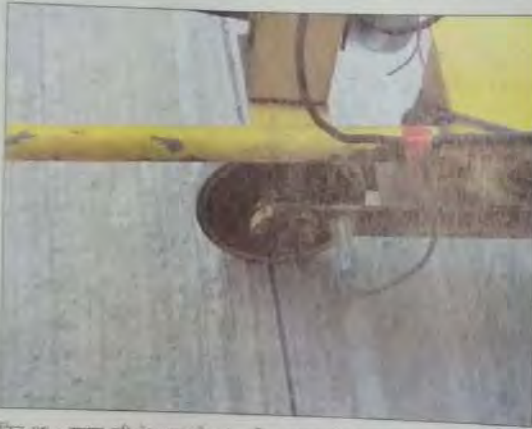
चित्र 60 : सड़क दूरी के मापन हेतु स्वचालित कप्लर की स्थापना
