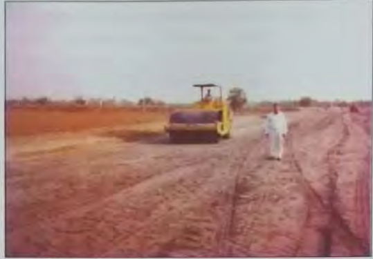
चित्र 19 : निर्माणाधीन उड़न राख तटबंध
