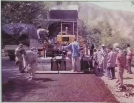
चित्र 34 : श्रीनगर (जम्मू व कश्मीर) के समीप राष्ट्रीय महामार्ग-1 ए पर परीक्षण खंडों का निर्माण
