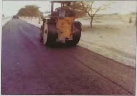
चित्र 31 : दमतीर-खाजूवाला मार्ग (राजस्थान) पर परीक्षण खंड का निर्माण
