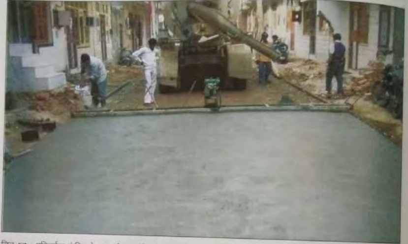
चित्र 57 : प्रतिदर्शक कंपित्र के द्वारा तैयार कुट्टिम गुणवत्ता कंक्रीट
