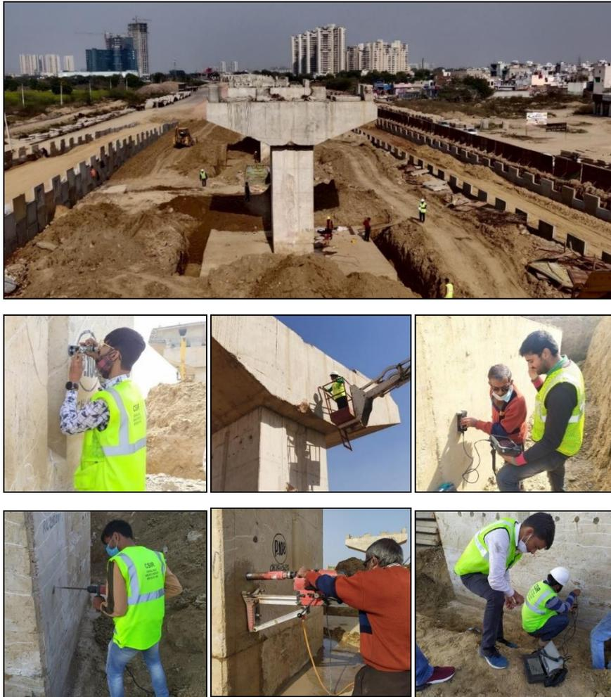
चित्र 10: दिल्ली में कार्यस्थल पर संरचनात्मक घटकों के एनडीटी परीक्षण का सामान्य दृश्य
