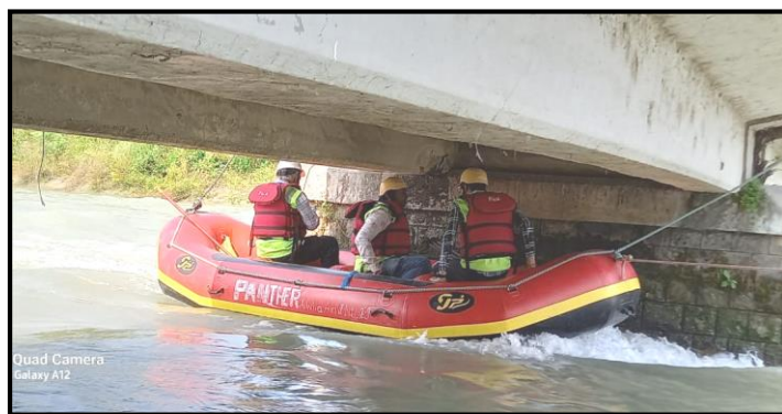
चित्र 8: देहरादून में राफ्टर का उपयोग करके सेतु के निरीक्षण का एक दृश्य
