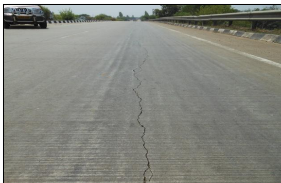
चित्र 10. कंक्रीट कुट्टिम में समयपूर्व अनुदैर्घ्य दरार
