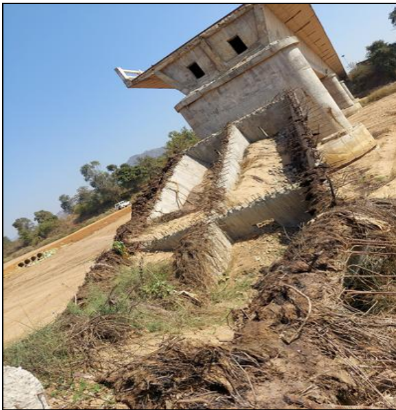
चित्र 5. तामिया मुदलसर रोड पर सुक्तल नदी पर बने पुल के टूटे स्पेन का दृश्य
