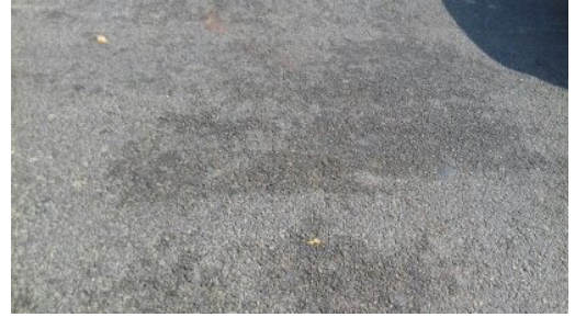
चित्र 3: कुट्टिम की निचली परतों से कुट्टिम की सतह पर आने वाले पानी को दिखाता दृश्य
