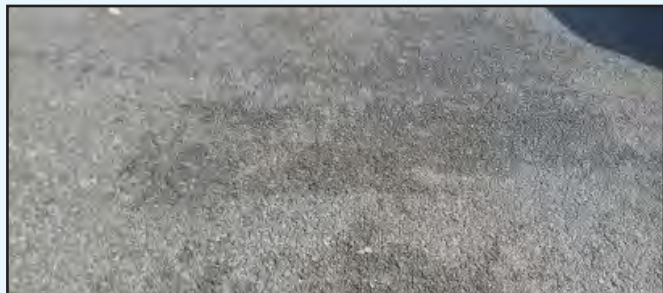
चित्र 3: कुट्टिम की निचली परतों से कुट्टिम की सतह पर आने वाले पानी को दिखाता दृश्य
