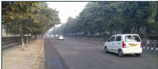
चित्र 3: कुट्टिम की निचली परतों से कुट्टिम की सतह पर आने वाले पानी को दिखाता दृश्य
