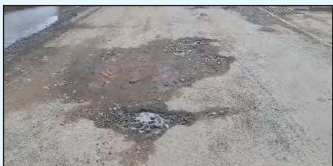
चित्र 4 : ईंटों व पेवर ब्लॉकों का उपयोग करके गड्ढों की मरम्मत के कार्य का एक दृश्य
