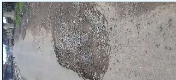
चित्र 2 : गड्ढों के निर्माण के कारण क्षतिग्रस्त सड़क एवं सड़क सतह में ग्रेनुलर सतह का अनावरण
