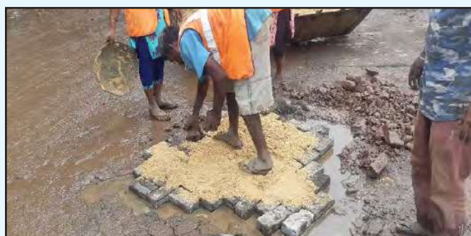
चित्र 4 : ईंटों व पेवर ब्लॉकों का उपयोग करके गड्ढों की मरम्मत के कार्य का एक दृश्य
