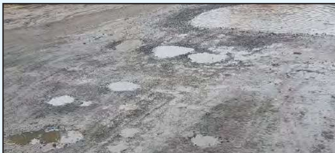
चित्र 2 : गड्ढों के निर्माण के कारण क्षतिग्रस्त सड़क एवं सड़क सतह में ग्रेनुलर सतह का अनावरण
