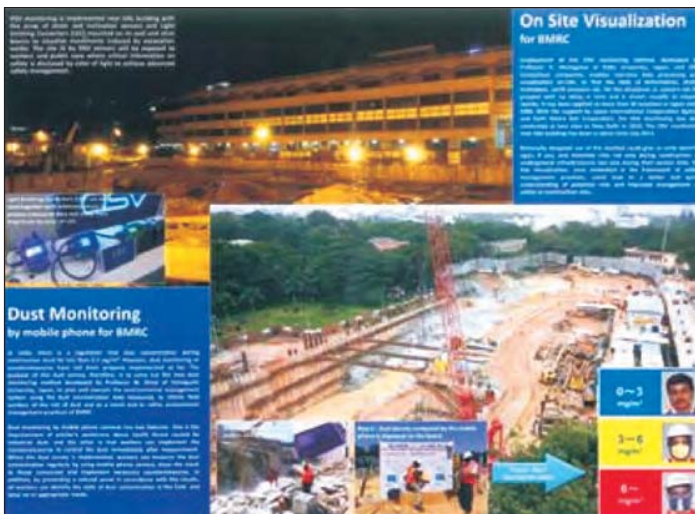
चित्र 146 ओएसवी के प्रयोग से क्रिकेट स्टेडियम मेट्रो स्टेशन में सुरक्षा का मॉनीटरन तथा सेंट्रल कॉलेज स्टेशन बेंगलूर में धूल मॉनीटरन
