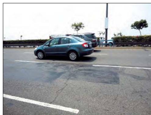
चित्र 56 डीएनडी फ्लाईवे (दिल्ली से नोएडा) के मुख्य यानमार्ग पर अनुप्रस्थ विदारण एवं दसर संवरण
