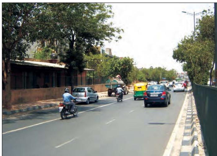
चित्र 48 अपशिष्ट प्लास्टिक के प्रयोग से तप्त एस्फाल्ट मिश्र निर्मित सड़क खंड
