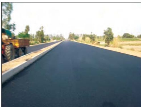
चित्र 30 रोहतक-भिवानी सड़क पर प्लास्टिक अपशिष्ट आशोधित मिश्र से निर्मित सतह
