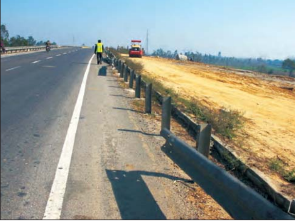
चित्र 98 राष्ट्रीय महामार्ग-24 के मुरादाबाद-बरेली सड़क खंड पर किमी 159.760 पर सड़क उपयोगकर्ता हेतु सुरक्षा जोखिम के रूप में क्षतिग्रस्त टक्कर अवरोधक (डब्ल्यू-शहतीर)
