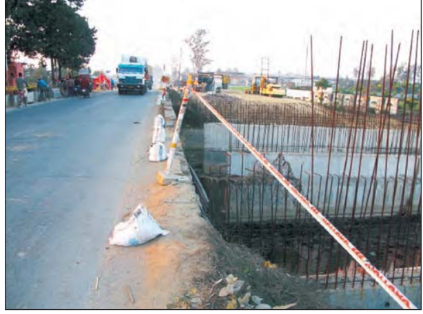
चित्र 99 राष्ट्रीय महामार्ग-24 के मुरादाबाद-बरेली सड़क खंड पर किमी 261.000 पर अपर्याप्त बाड़ एवं विभाजन
