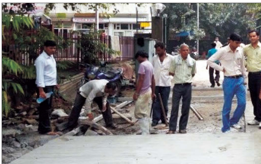
चित्र 43 अति तनु श्वेत शीर्ष का चालू निर्माण
